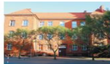
Budynek dawnego więzienia
